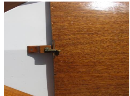
De gamle vingebeslag skal efterspændes De er tit for løse.
